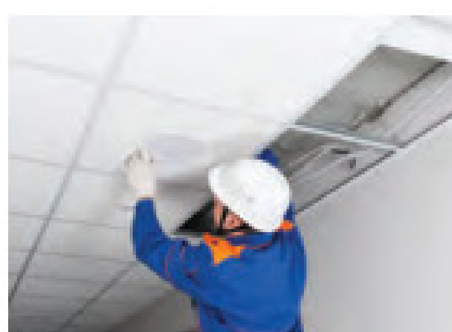
c) Thợ lắp điện cho toà nhà
