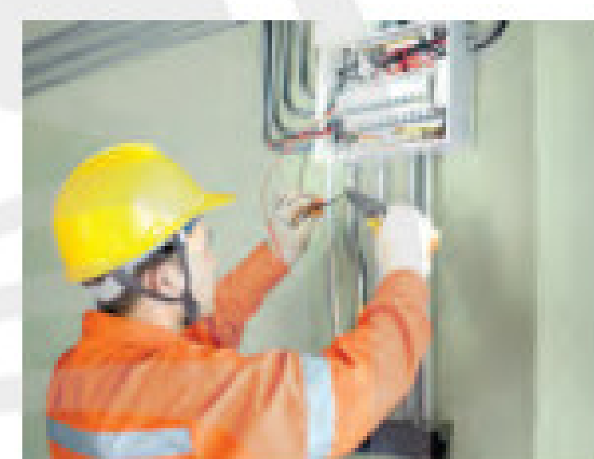
d) Lắp đặt mạng điện trong nhà
